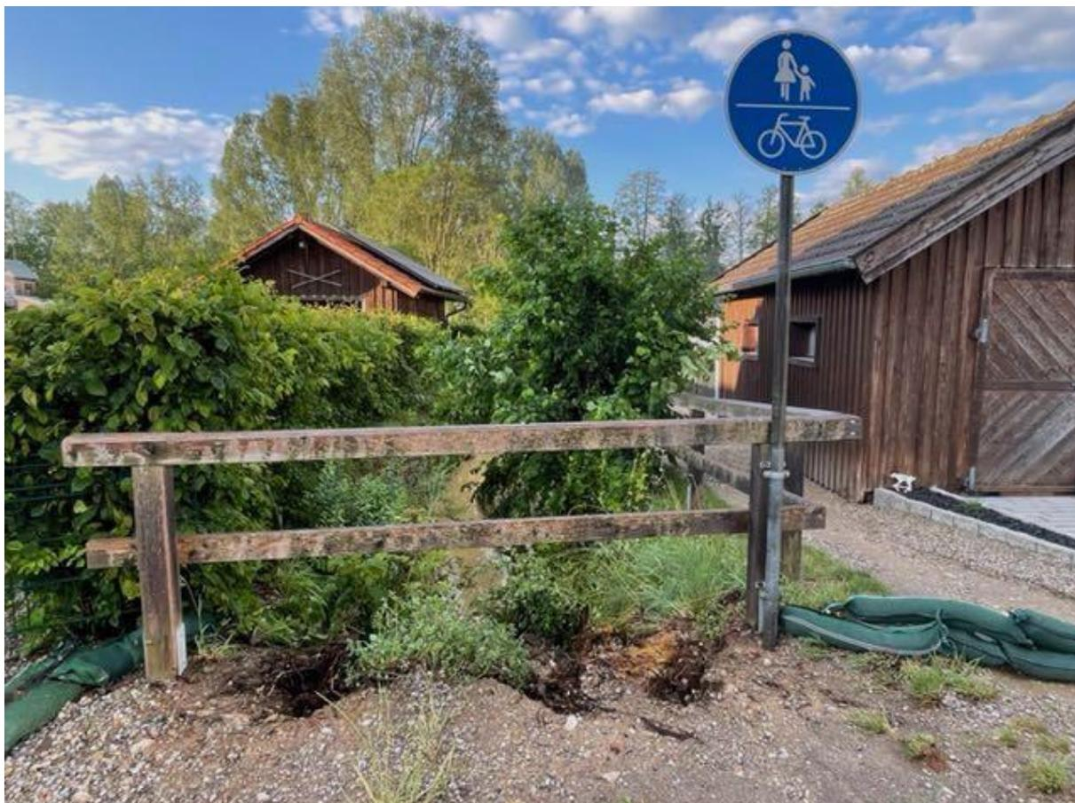
05.06.2022 Links und rechts vom Görgebach befinden sich Einfamilienhäuser. Die Wassermassen haben in 2022 erstmalig die Befestigung des Hangs zerstört.
